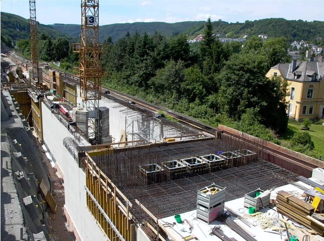
Les cheminées pour les ventilateurs d'extraction des fumées sont placées de préférence sur la partie supérieure du tunnel afin d'éliminer de manière sûre tous les gaz de fumées et d'incendies. Un équipement séparé est prévu pour la ventilation du tunnel et de contrôle des immissions (09 Juin 2003).
